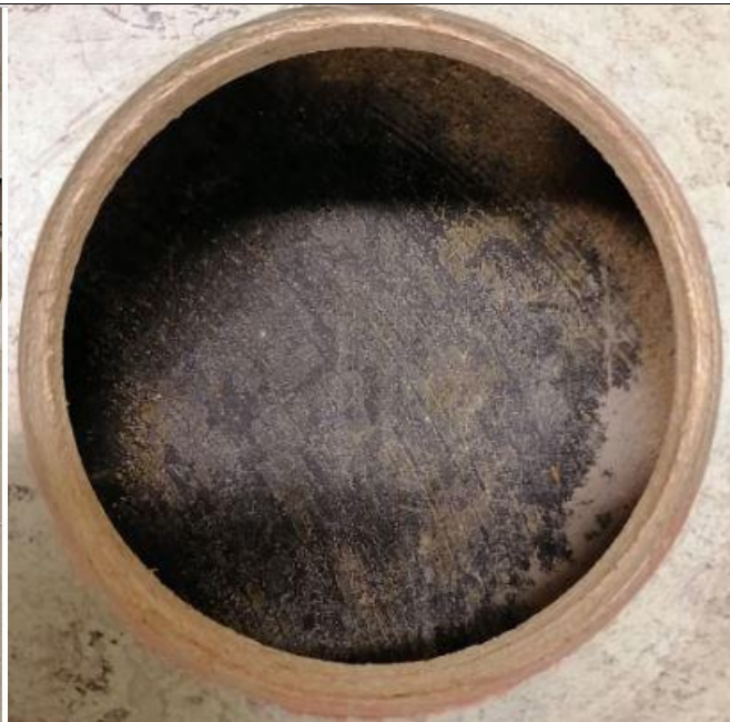
Kuva 4. Tilan 204.1 (R1, VP) korokkeen ylimmän tason rakenneavaus. Mustassa pintasivelyssä ei ollut asbestia eikä PAH-aineita.
