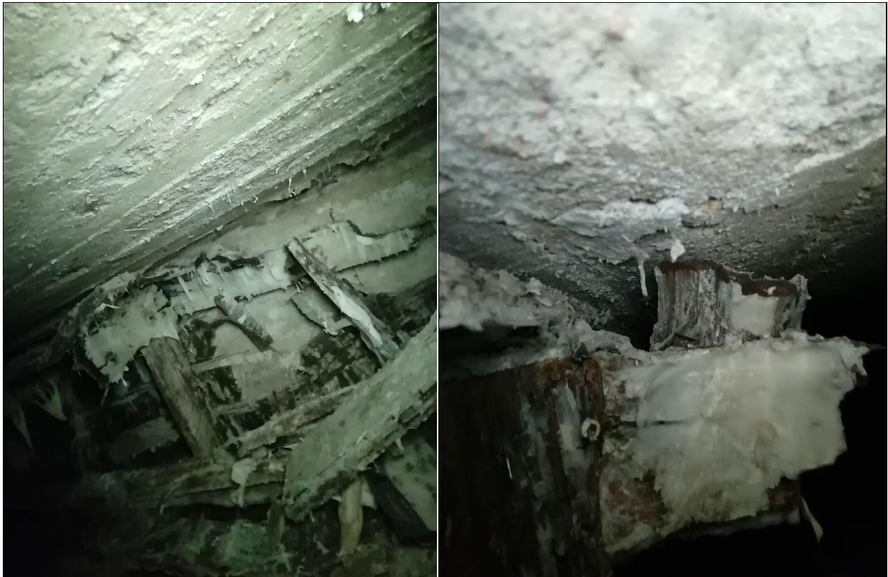
Kuvat 1 ja 2. Muottilaudat olivat lahonneita ja pinnalla oli vanhaa valkoista kasvustoa.
